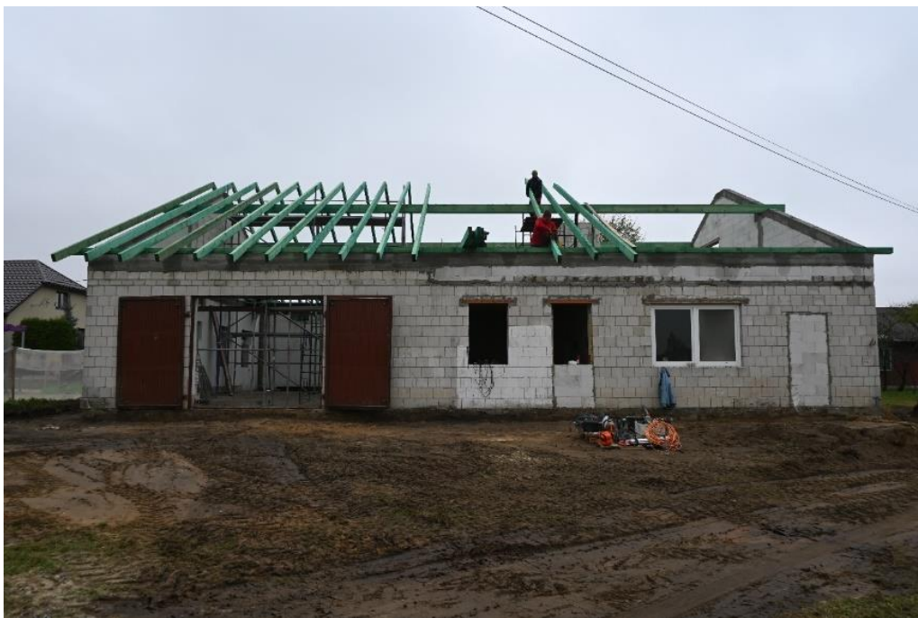
Zdjęcie 10. Przebudowa budynku w Grodzisku i dostosowanie do działalności świetlicy.
